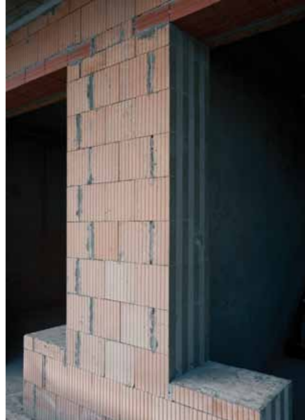
SYSTEMSTÜRZE AN DEN WOHNUNGSEINGÄNGEN LAUBENGANG
