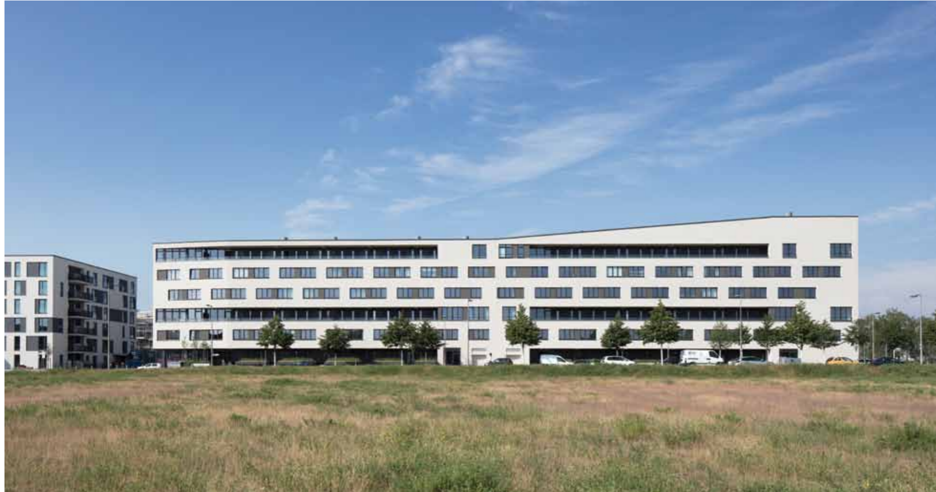
FERNWIRKUNG: DIE STRASSENFASSADE MIT IHRER CHARAKTERISTISCHEN HORIZONTALEN GLIEDERUNG DURCH DIE EINGESCHNITTENEN LAUBENGÄNGE
