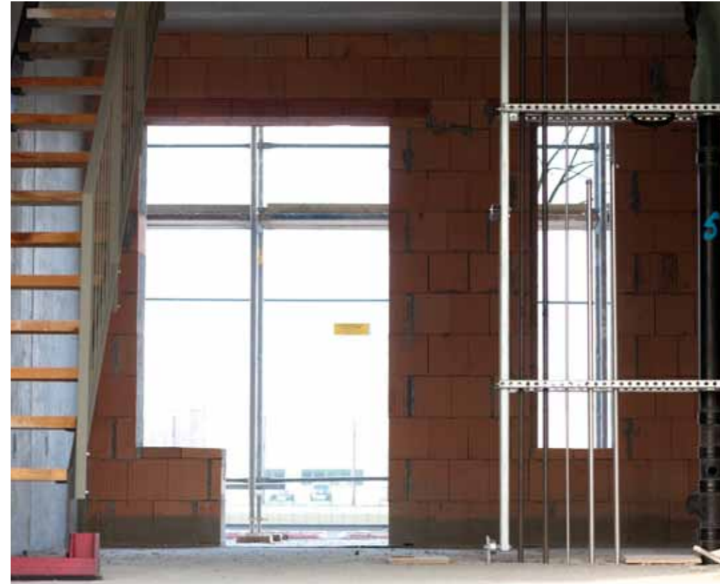
BAUZEIT: EINGANGSBEREICH EINER MAISONETTE MIT INTERNER TREPPE UND TRAGGESTELL FÜR INSTALLATIONEN
