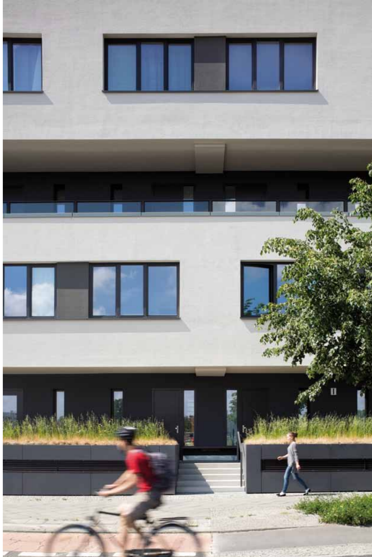
LAUBENGÄNGE UND VORZONEN IM ERDGESCHOSS: HALBÖFFENTLICHE BEREICHE AM GROSS-BERLINER-DAMM
